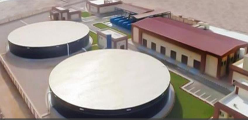
محطة معالجة الصرف الصحي بمدينة الطور
